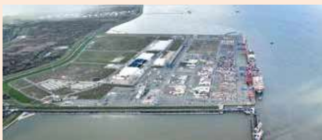
Am JadeWeserPort befindet sich das Bulk Terminal Wilhelmshaven, hier könnte die Eisenerz-Direktreduktionsanlage mit vorgeschalteter Wasserstoff-Elektrolyse entstehen | Bild: JWP
